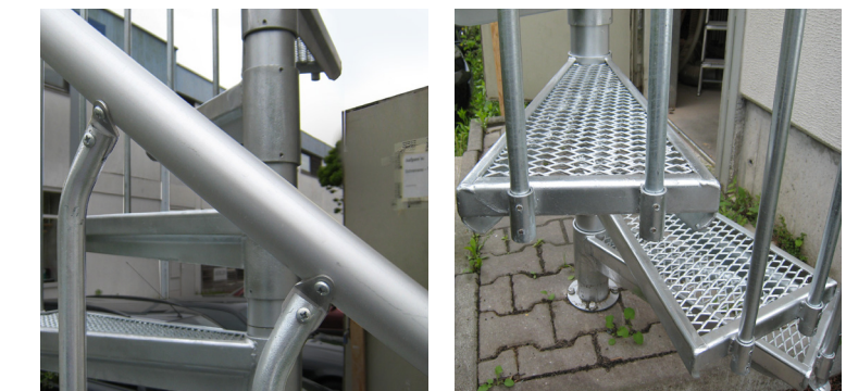
Befestigung des Handlaufs an den Geländerstäben
