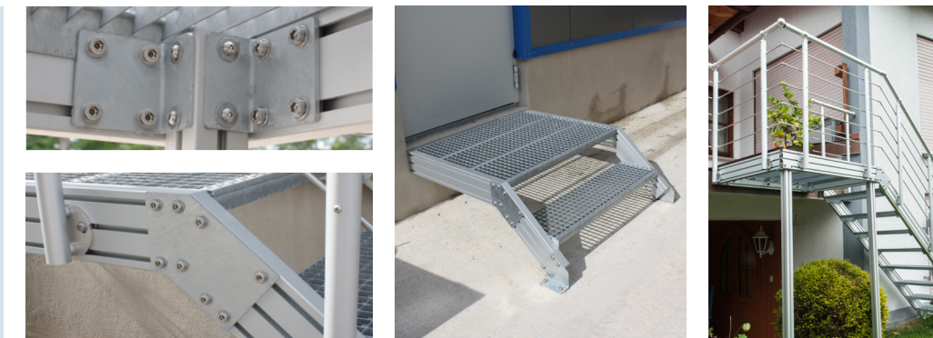
Befestigung der Stufen am Standrohr
