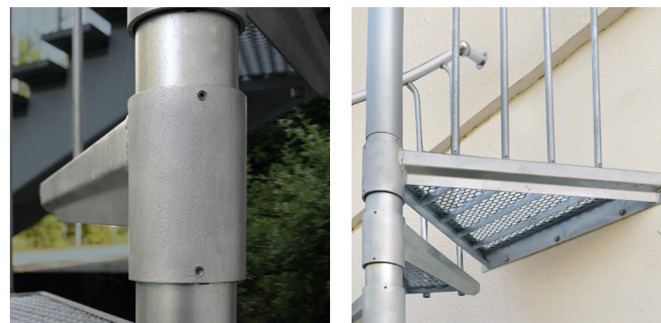
Befestigung der Geländerstäbe an den Gitterroststufen + Standrohr am Boden
