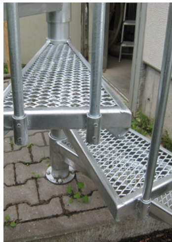
Befestigung der Geländerstäbe an den Gitterrost-Stufen und Standrohr am Boden
