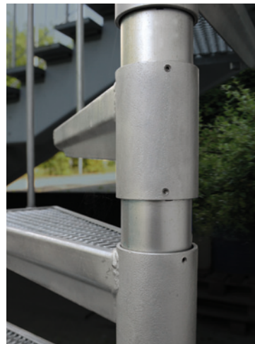
Befestigung der Stufen am Standrohr
