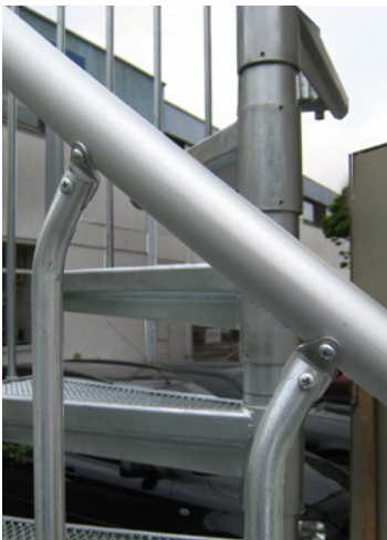
Befestigung des Handlaufs an den Geländerstäben
