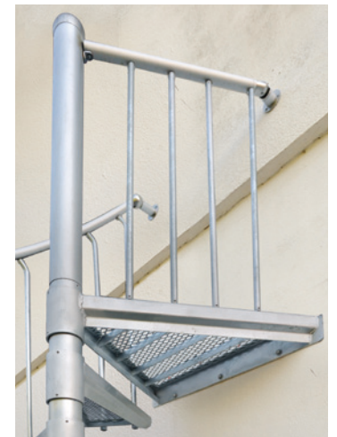
Befestigung des Podestes an der Wand
